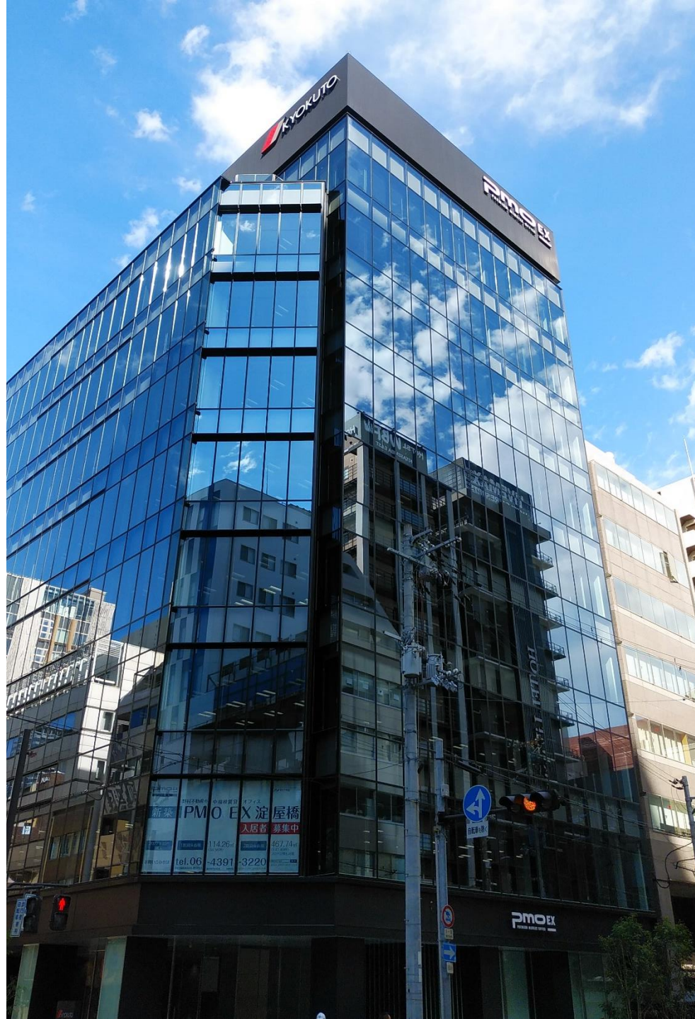
PMO EX淀屋橋
