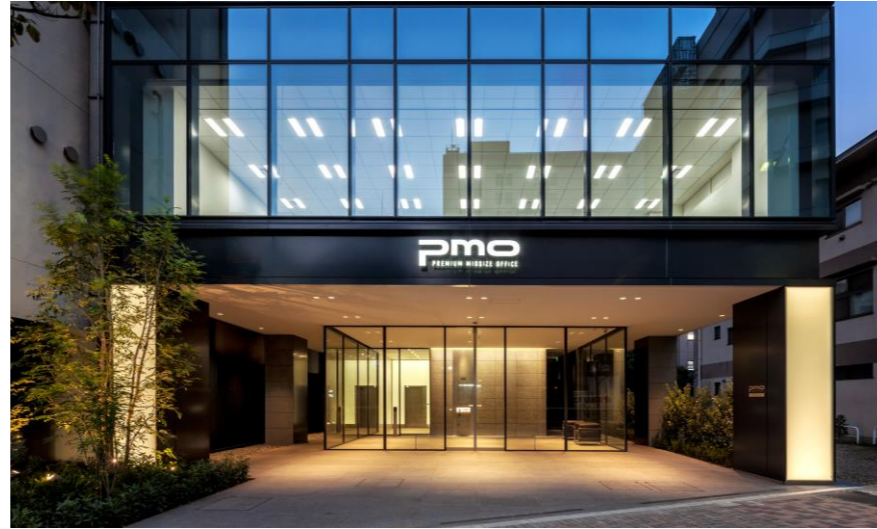
格調高いエントランスホール
