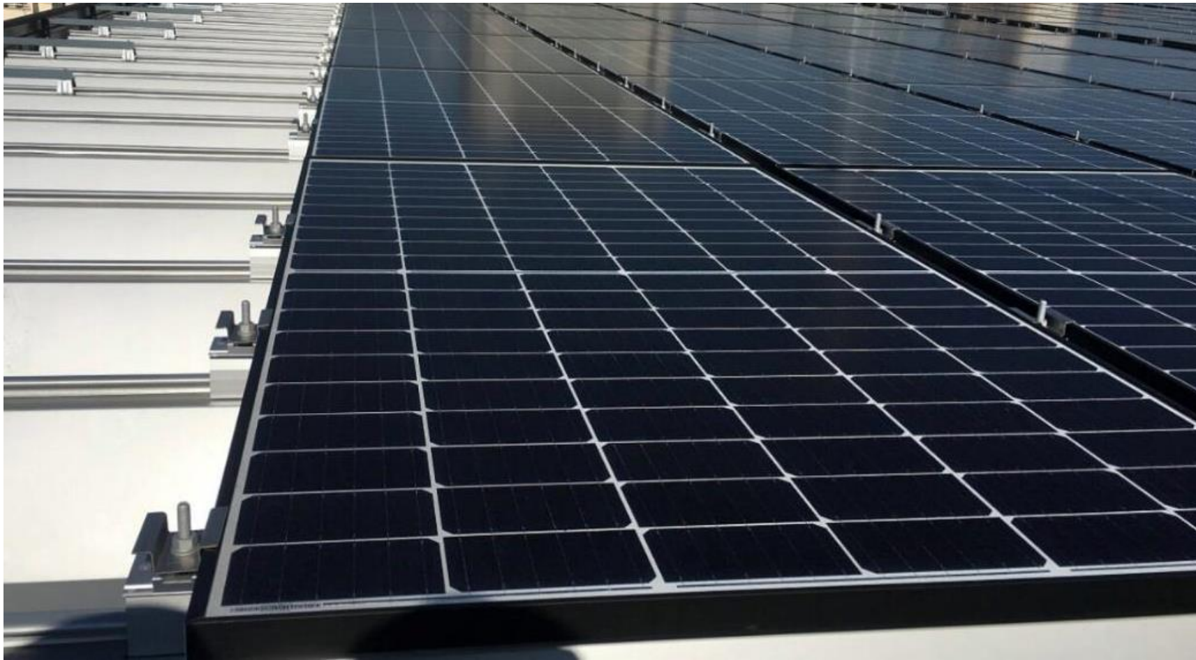
レンタルオフィスの屋根／太陽光発電設置工事
