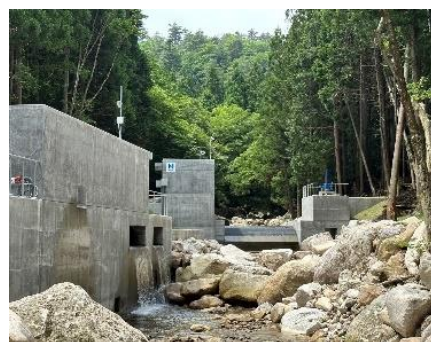
小水力発電 (滋賀県高島市・FIT)
