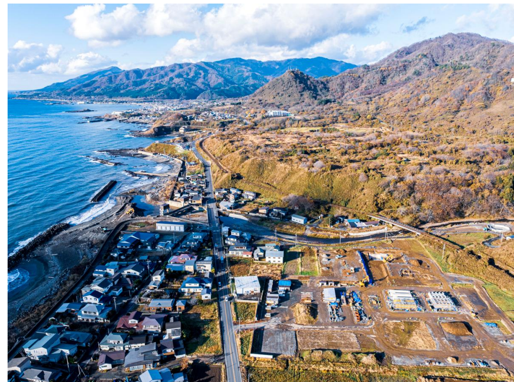
泊川中間養殖場建設地（2024年11月撮影）
