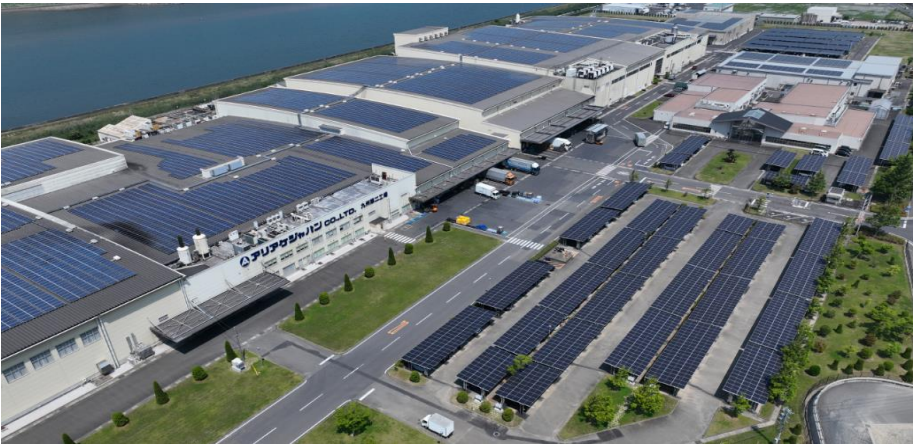
九州第二工場 自家消費型太陽光発電システム
