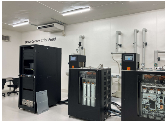
▲ 機器設置状況
