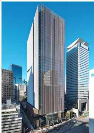
虎ノ門アルセアタワー (複合開発・電気)
