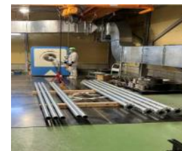
配管フレア加工
