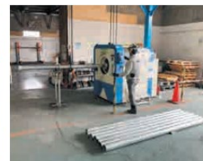
配管プレ加工
