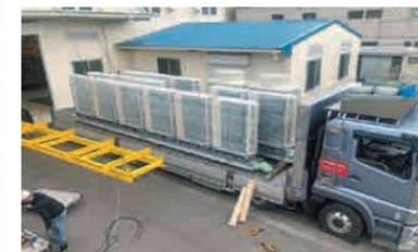
搬出される加工済み空調室外機ユニット
