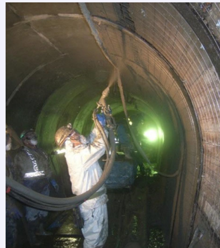
導水路内でのキロ・フケール工法による吹付け
