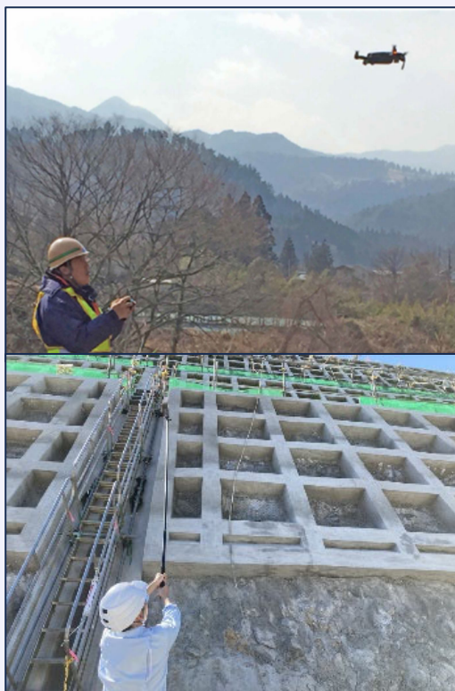
① UAVやスマートフォンで吹付法面の画像を撮影
