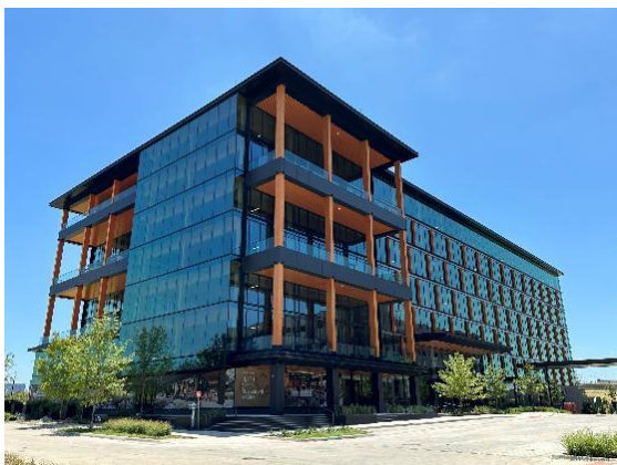
6階建ての木造オフィスビル（テキサス州ダラス）
