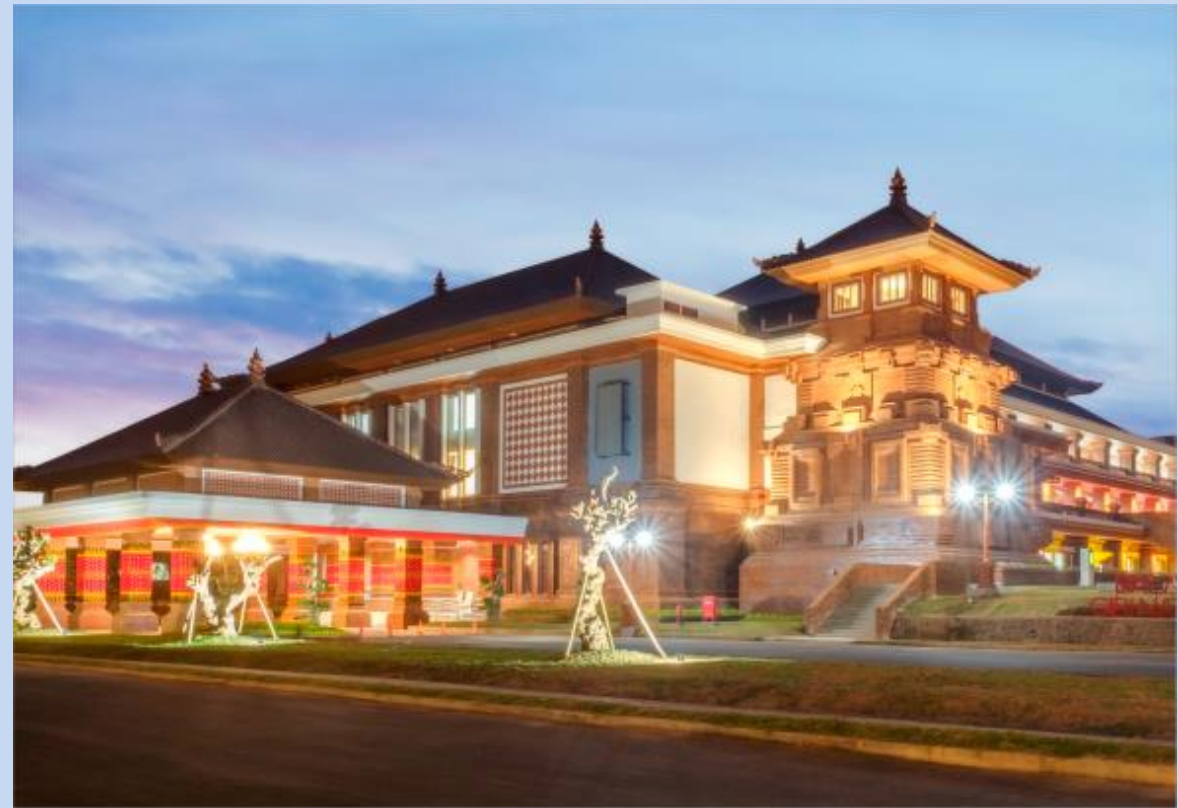
バリ芸術劇場建設工事
