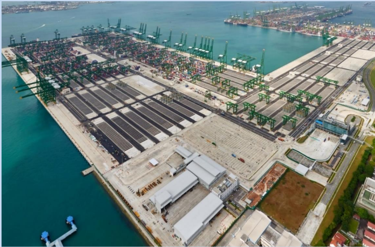
パシルパンジャン地区コンテナターミナル工事
