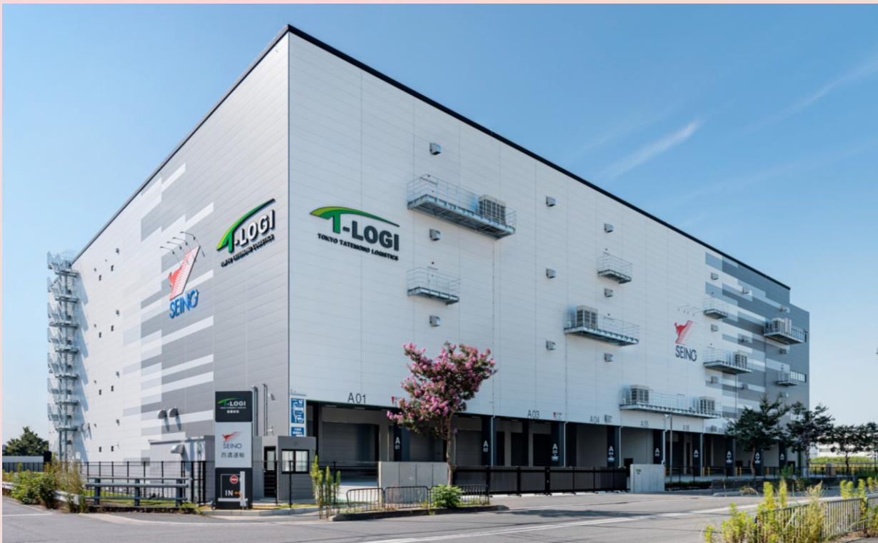
T-LOGI京都伏見（建設工事）
