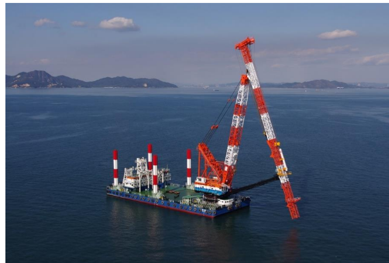
杭打ち兼起重機船 「鶴隆」
