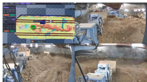
ケーソン工法無人化掘削システム
