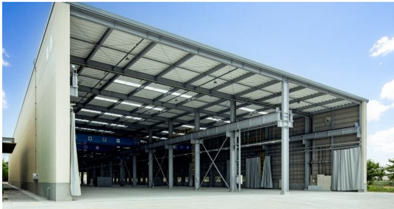
新設されたライン棟
