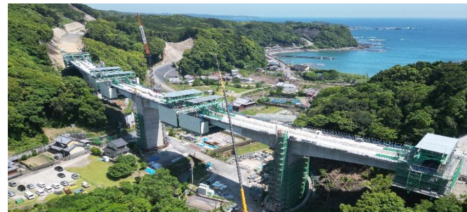
すさみ串本道路江田川橋上部工事 山間部で張出架設で施工するPC4径間連続ラーメン箱桁橋
