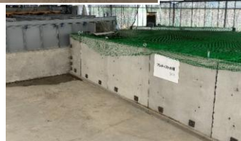
鋼製水槽・ PC水槽
