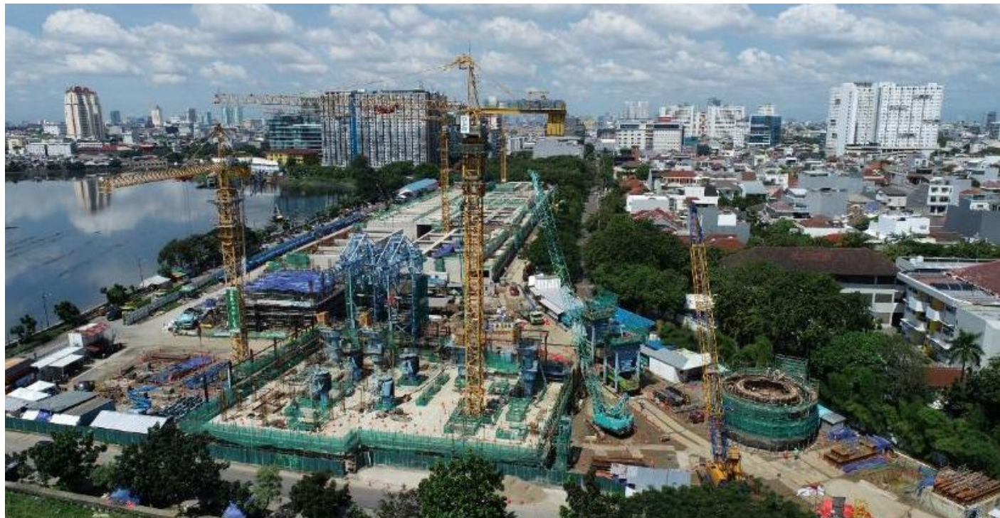
ジャカルタケーソン工事
