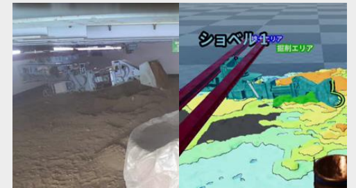
図-1 自動運転システムによる掘削 (左:地下空間、右:地上可視化画面)
