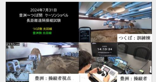
図-2 豊洲オフィスとつくば研修施設間の遠隔操縦試験
