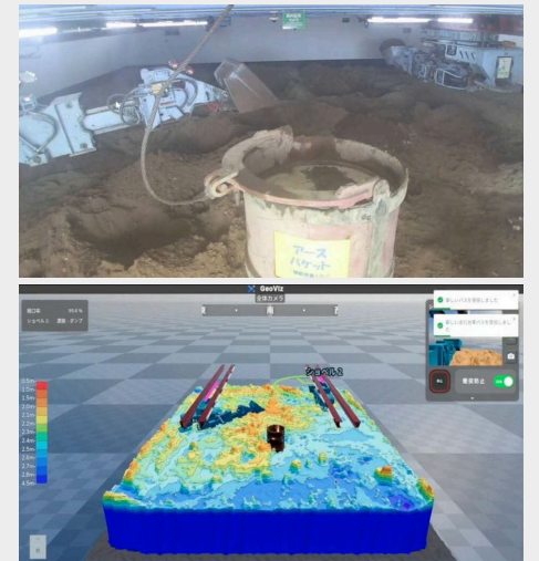
図-1 地盤計測システムによる 地下空間の3Dデジタルツイン
