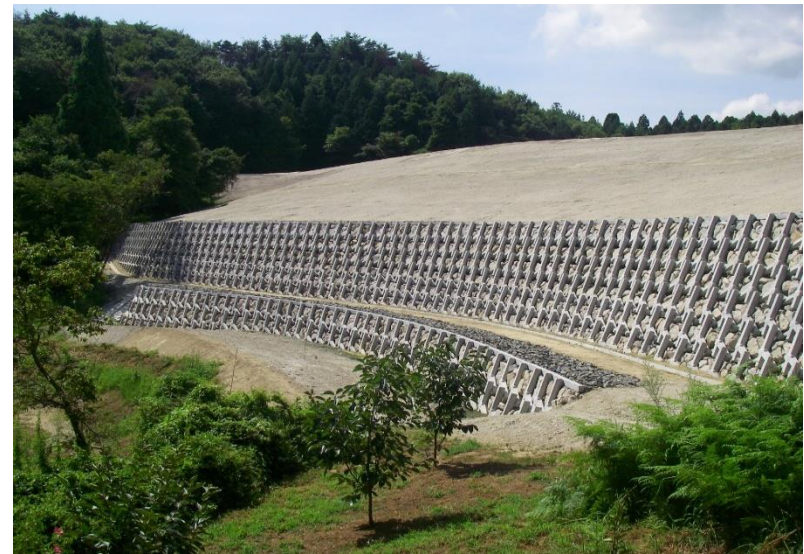
工業団地崩壊法面復旧工事 ブランチブロック（茨城県）
