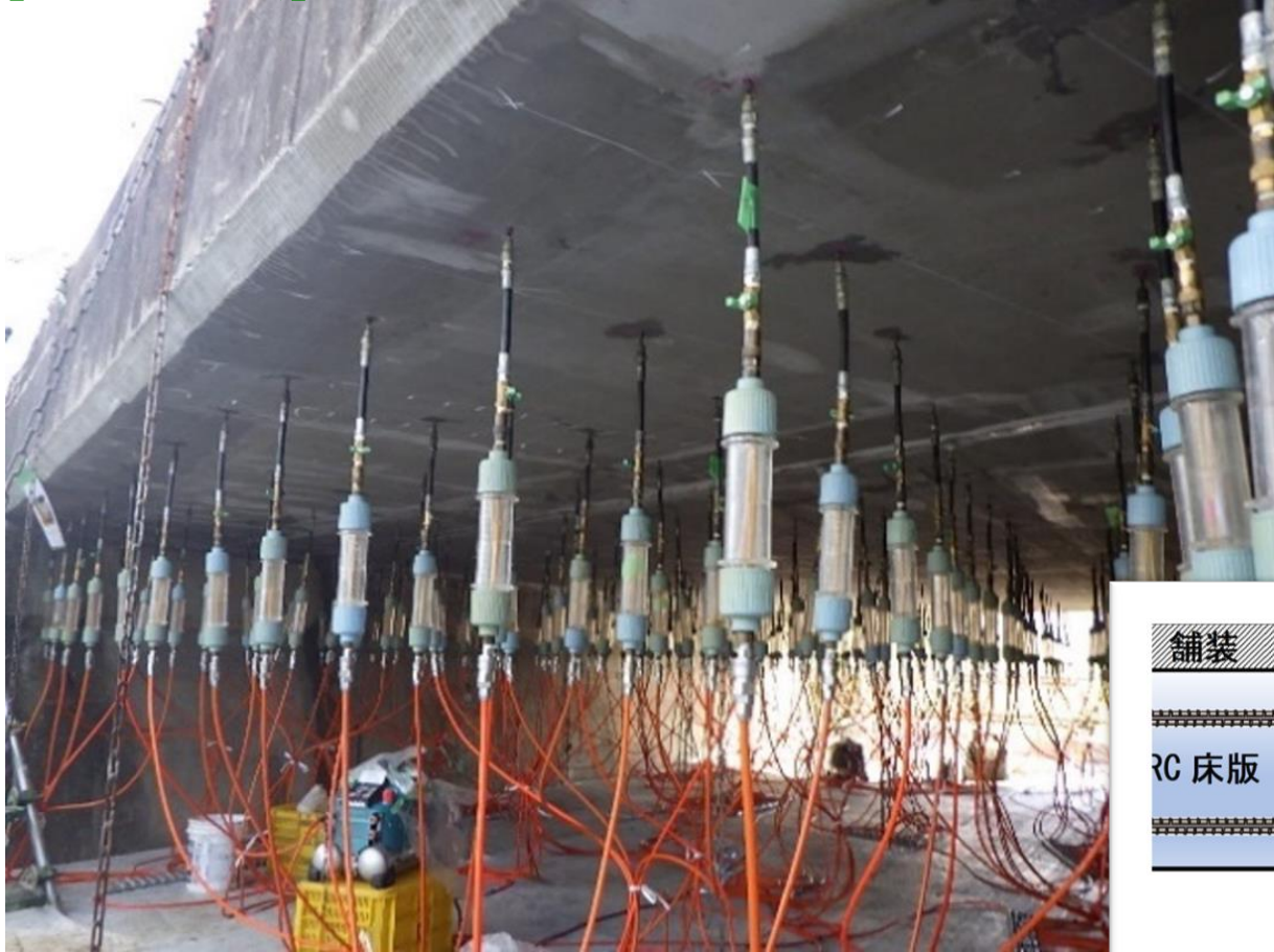
上大橋補修工事（和歌山県）
