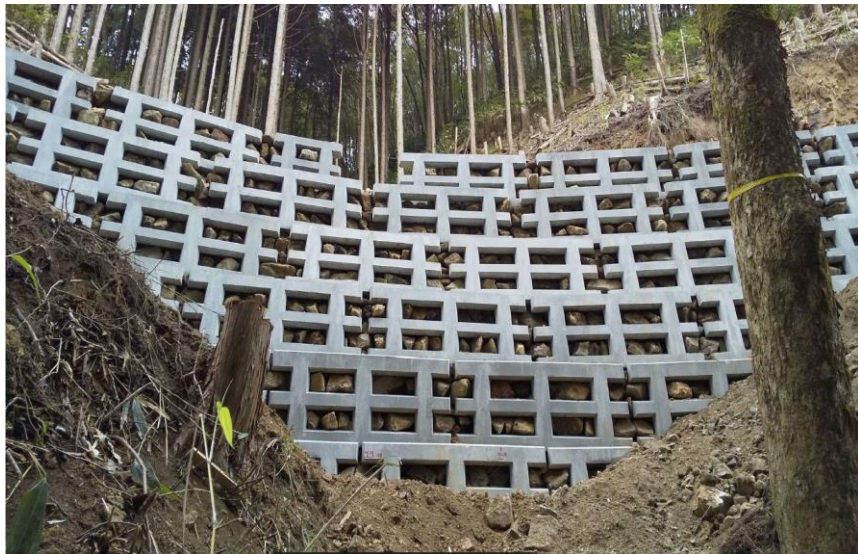
入江山林業専用道新設工事（島根県）
