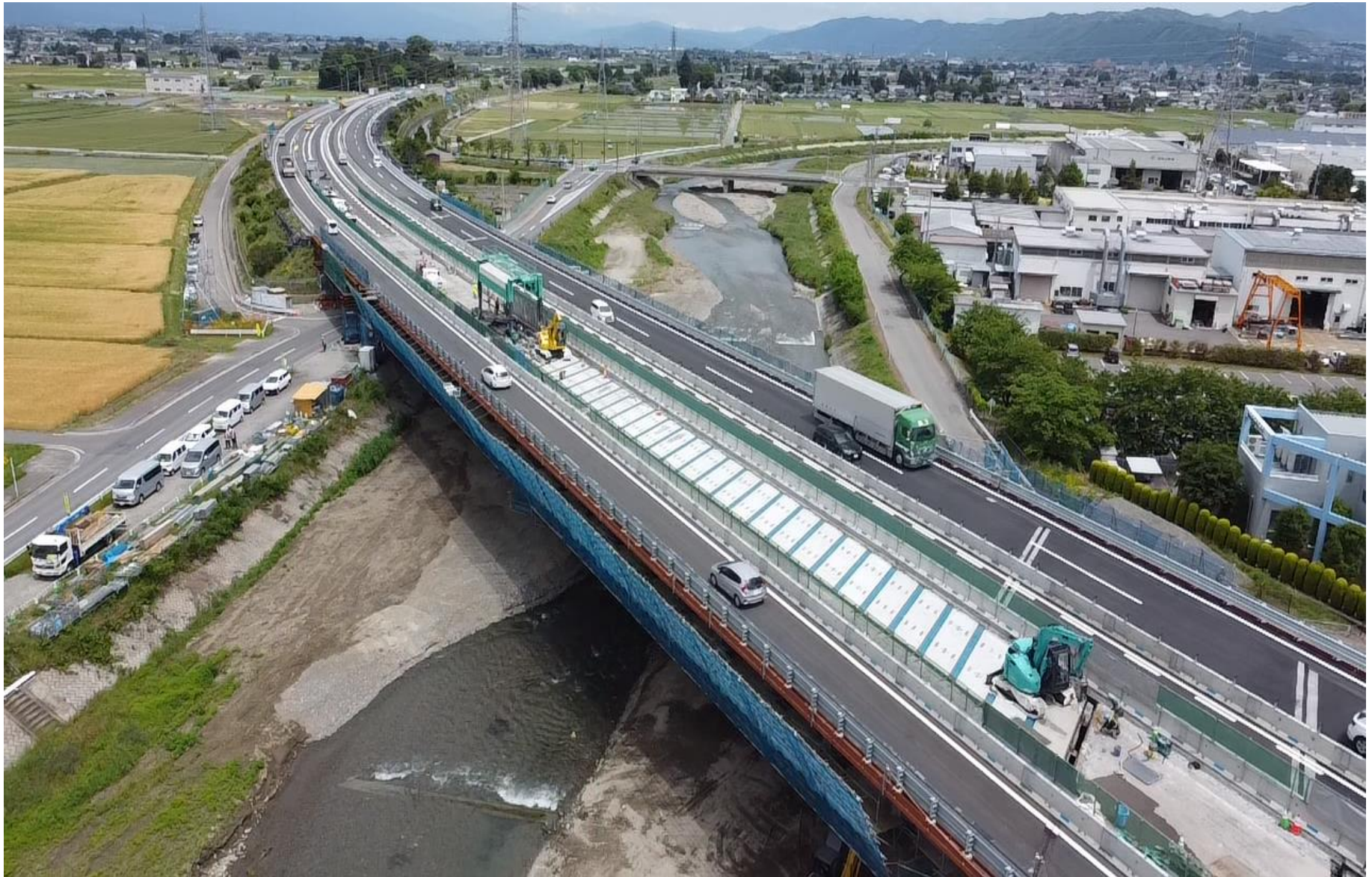
中日本高速道路株式会社八王子支社 長野自動車道 鎖川橋床版取替 長野県塩尻市
