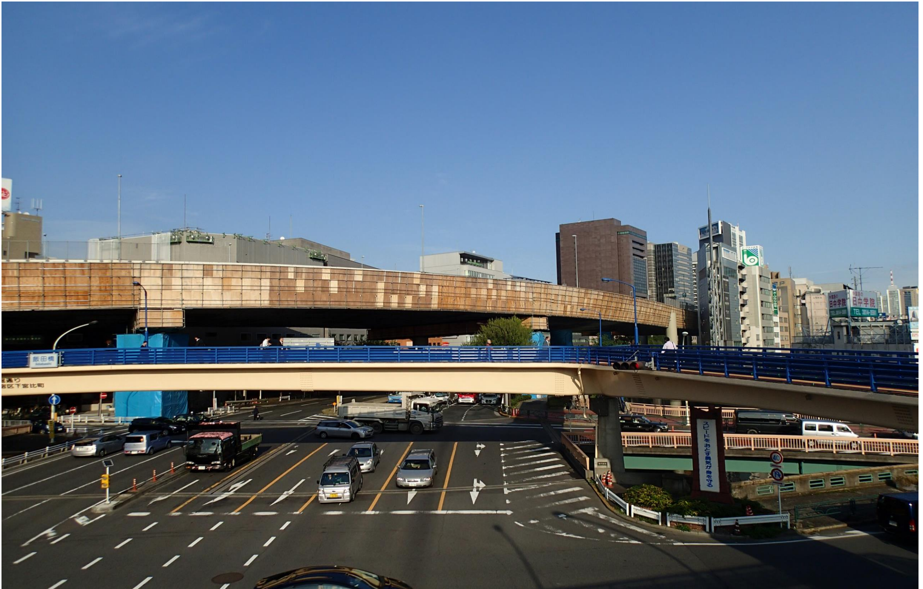
首都高速道路株式会社 飯田橋補強工事 東京都千代田区
