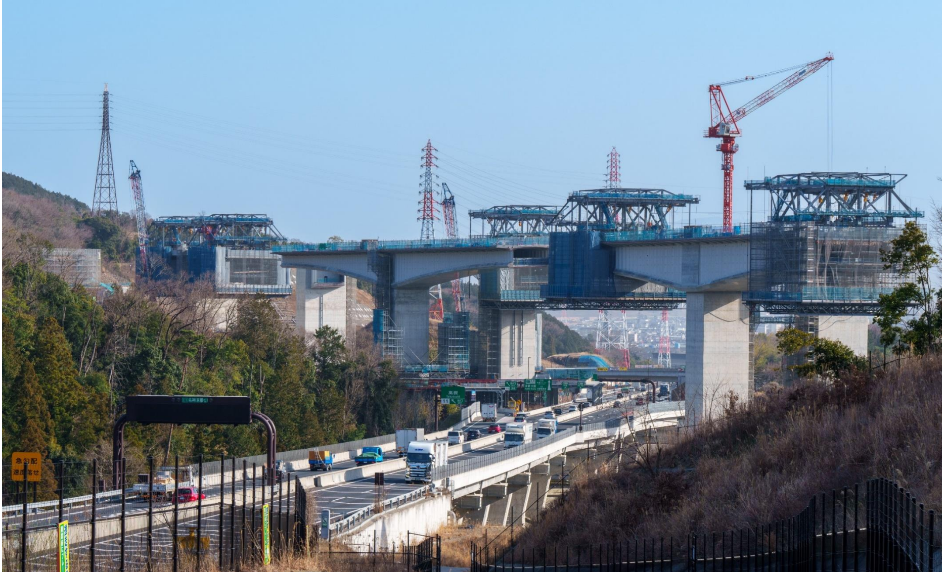
西日本高速道路株式会社関西支社 新名神高速道路 成合第一高架橋 大阪市高槻市
