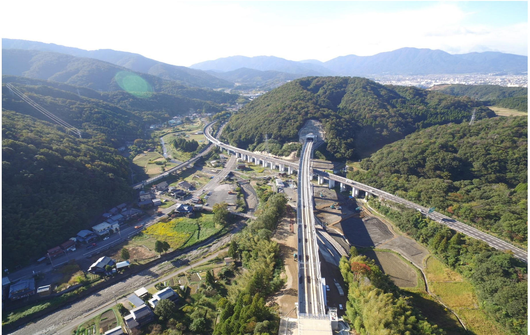
鉄道建設・運輸機構 鉄道建設本部株式会社 北陸新幹線 深山トンネル他 福井県敦賀市
