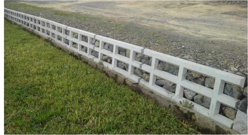
敷地内土留め工事（山口県）
