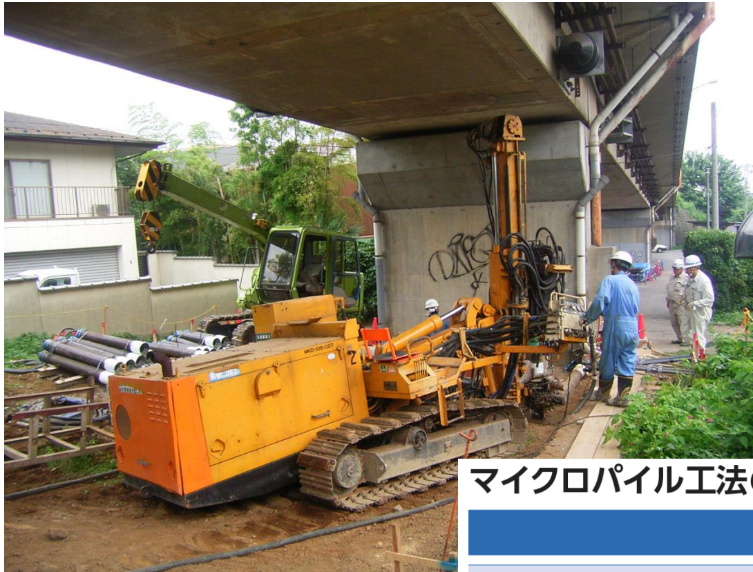
柿生陸橋橋梁補修(耐震補強)工事（神奈川県）
