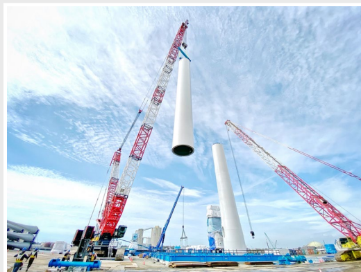
クレーン（洋上風車組み立て）
