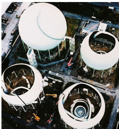
ガスホルダー（リンゴ皮むき工法）
