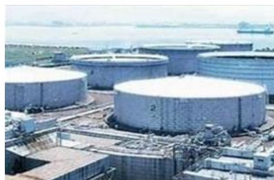
石油貯蔵タンク
