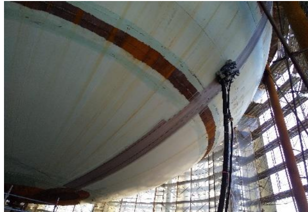
三谷産業ブラストマシンによる剥離
