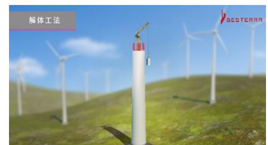
タワークレーン工法
