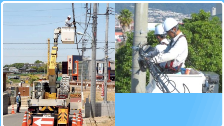
NTT通信設備工事
