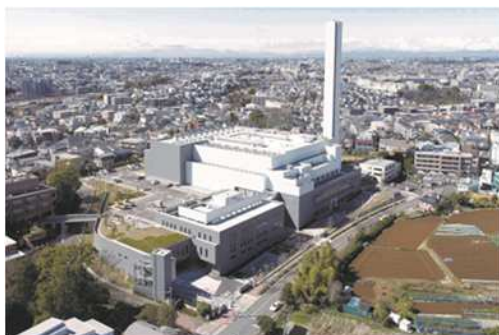
橋処理センター外観
