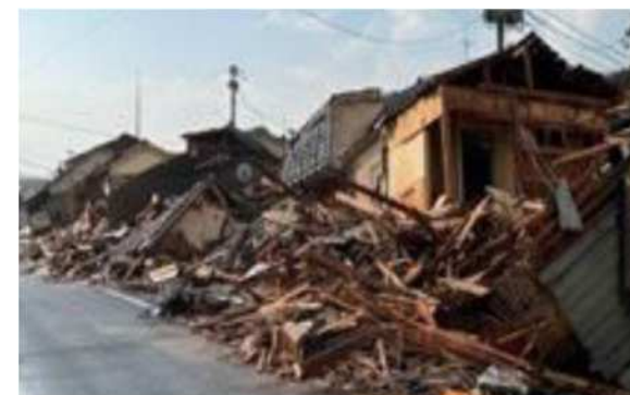
図1: 令和6年能登半島地震で倒壊した建物
