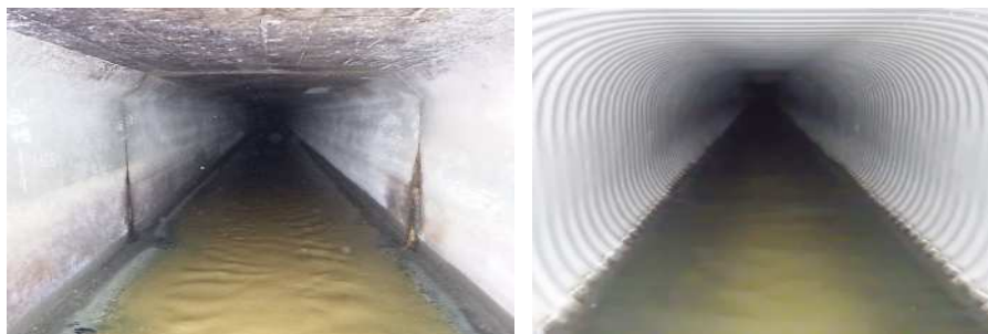
管さよの耐震化(左:耐震化前、右:耐震化後)
