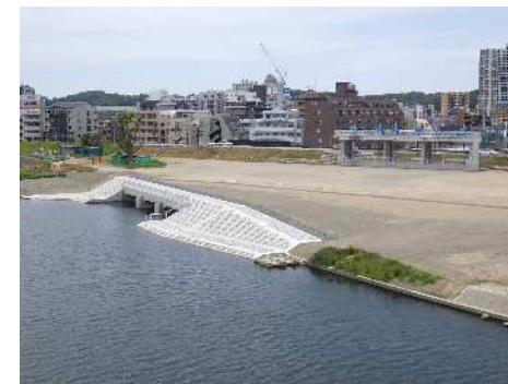
五反田川放水路（放流部）
