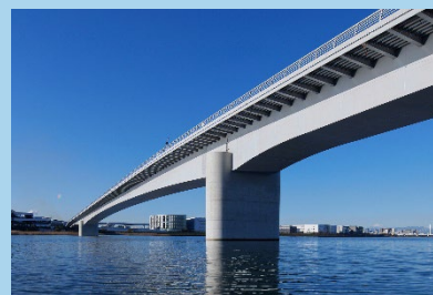
多摩川スカイブリッジ
