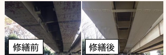
橋りょう修繕
