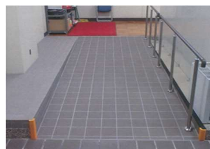
スロープの設置
