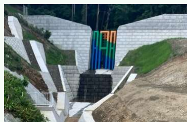
砂防関係施設整備
