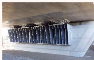
橋りょうの耐震化
