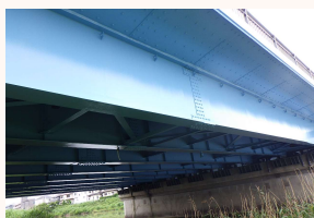
橋りょう修繕
