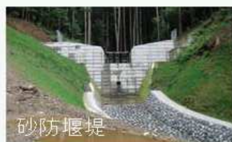
砂防関係施設整備
