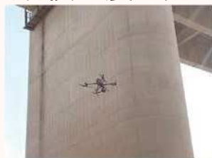
ドローンによる橋りょう点検
