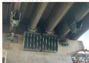
橋りょうの耐震化
