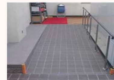
スロープ設置
