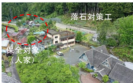
砂防関係施設整備
