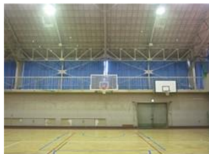
体育館の耐震化 (ブレース補強)
